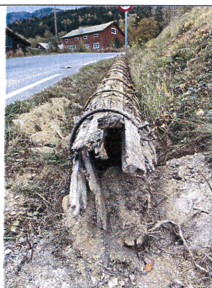
Stikkrenna ble skiftet ut under vedlikehold av Fv 375
