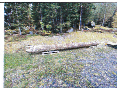
6,7 m av stikkrenna som foreløpig er lagt utendørs ved markedsbodene.
